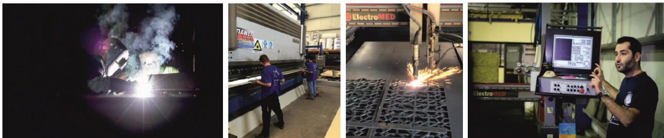
Λήψεις διαφόρων εργασιών που πραγματοποιούνται στο χώρο των Εγκαταστάσεων, όπως του παντογράφου σιδήρου.
